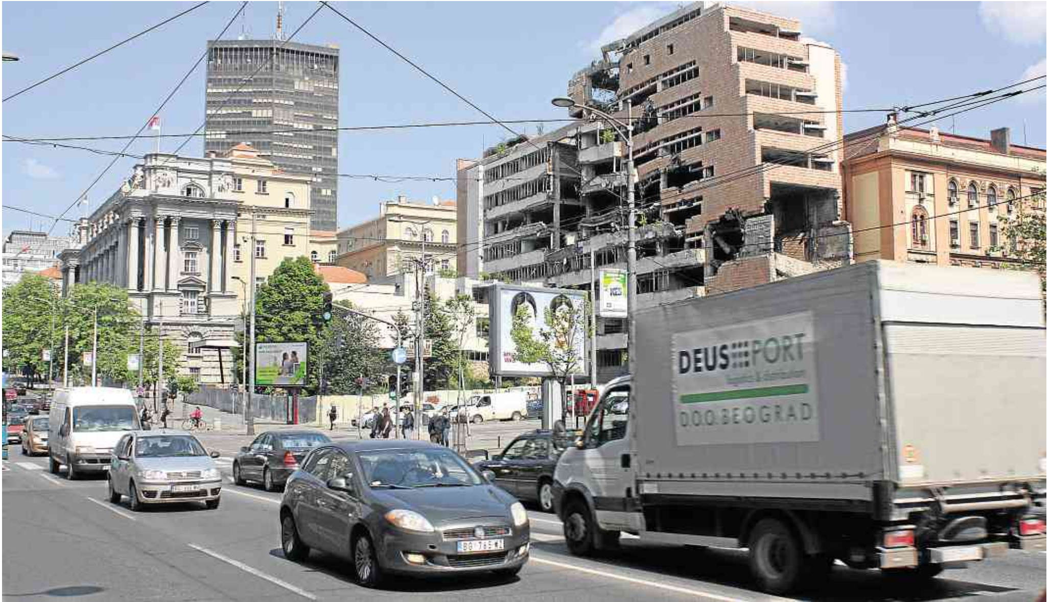
Serbien im Aufbruch zur EU? Im Regierungsviertel von Belgrad steht noch immer die Ruine des Verteidigungsministeriums, das die Nato 1999 im Kosovo-Krieg beschossen hatte. Fotos: R. Lehmann
